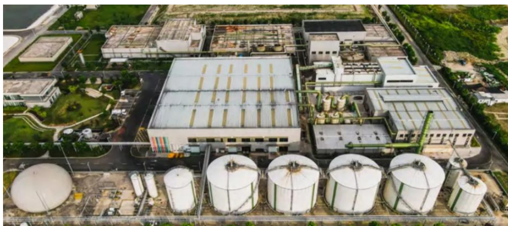
图 5-2 绍兴市餐厨和厨余协同处理项目
